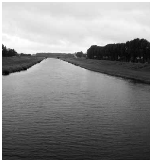
Fot. 4. Kanał Ulgi w pobliżu Opolą widziany z okna wagonu podczas podróży kolejowej do Wrocławia (fot. M. Bacik)
