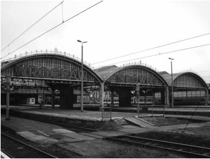
Fot. 5. Dworzec PKP Wrocław Główny z charakterystycznym zadaszeniem peronów (fot. M. Bacik)
