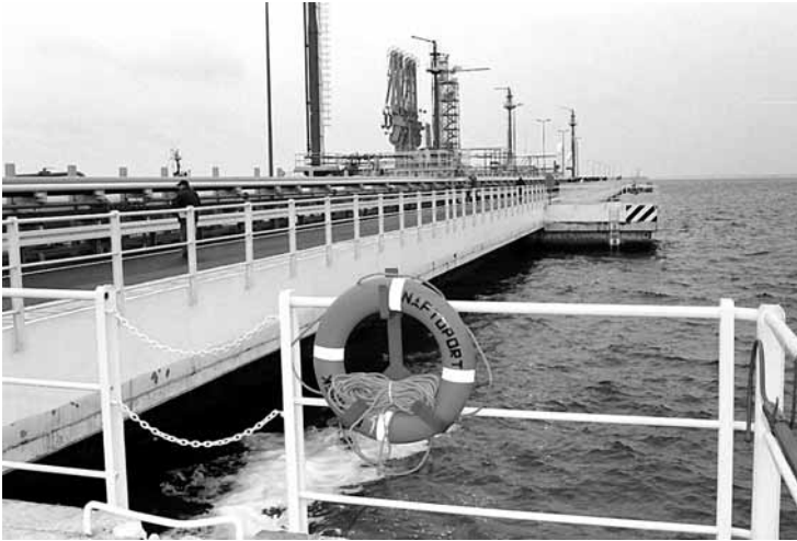
Fot. 1. Polska. Gdańsk. „Naf-toport” – trzecie stanowisko przeładunku ropy naftowej (do 12 mln t rocznie) (fot. PAP/Stefan Kraszewski)
