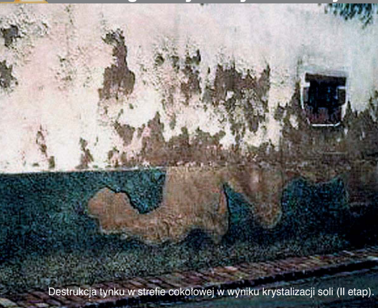
Destrukcja tynku w strefie cokolowej w wyniku krystalizacji soli (III etap).
