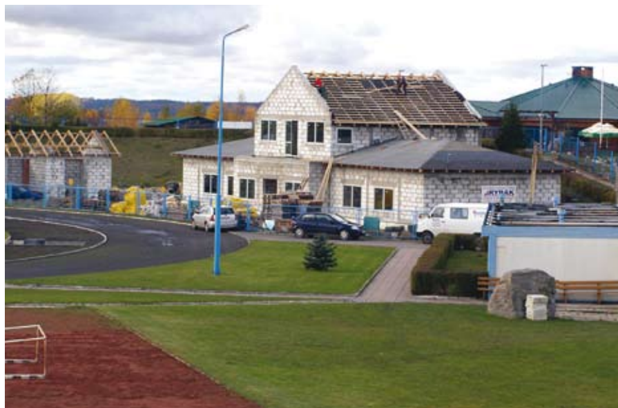
Budowa „Szatniowca”, czyli zaplecza stadionu piłkarskiego
