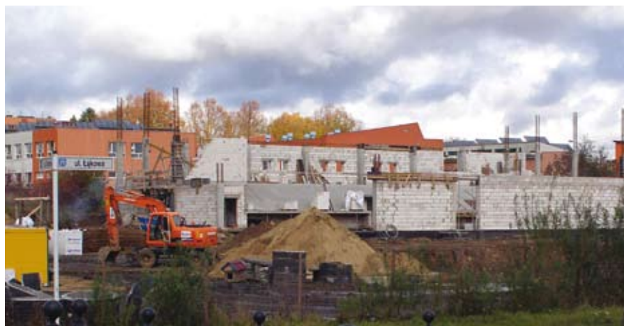
W Gniewinie ruszyły też prace przy wznoszeniu hali widowiskowo-sportowej
